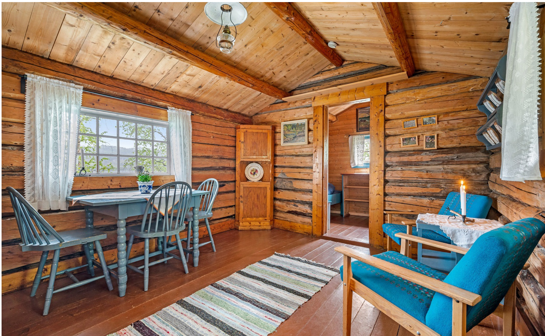
Hytta er oppført i tømmer. På gulv er det tregulv.
